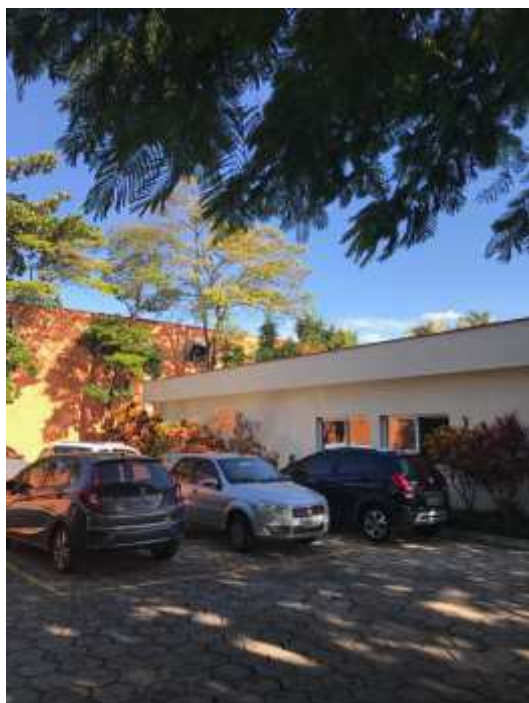
Foto 002: portaria e estacionamento.
