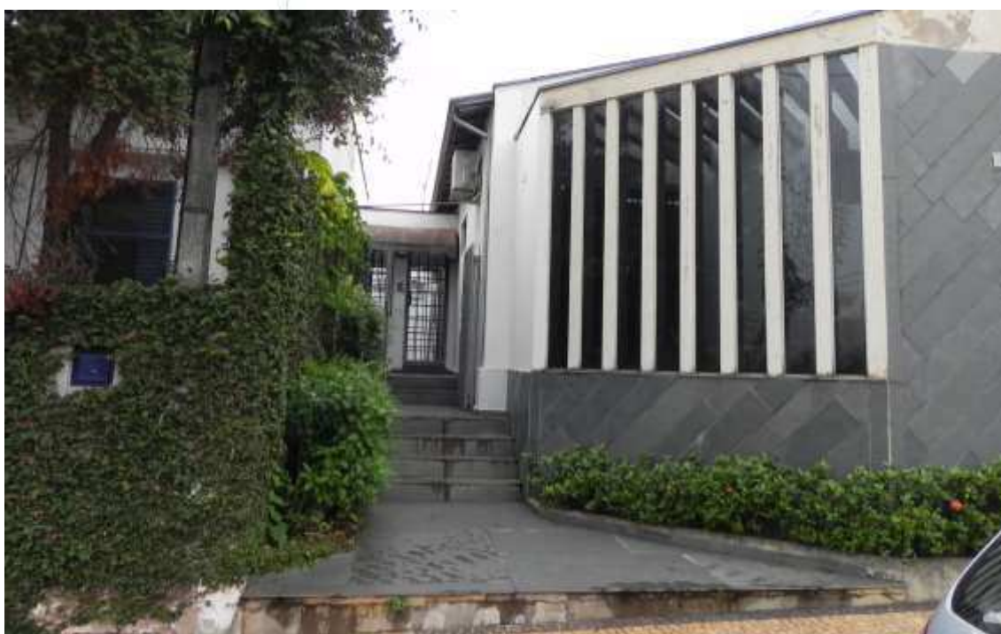
Foto 022: Entrada para o setor administrativo
