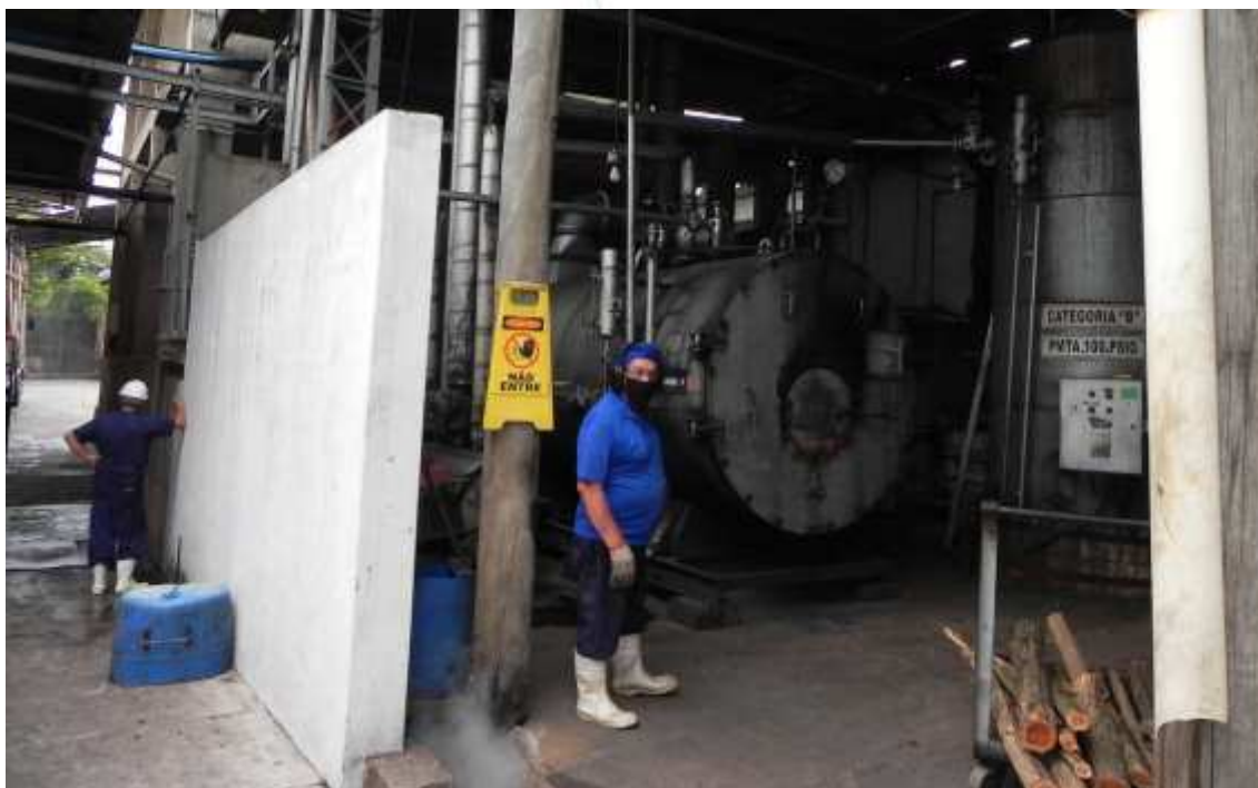
Foto 017: Galpão das máquinas
