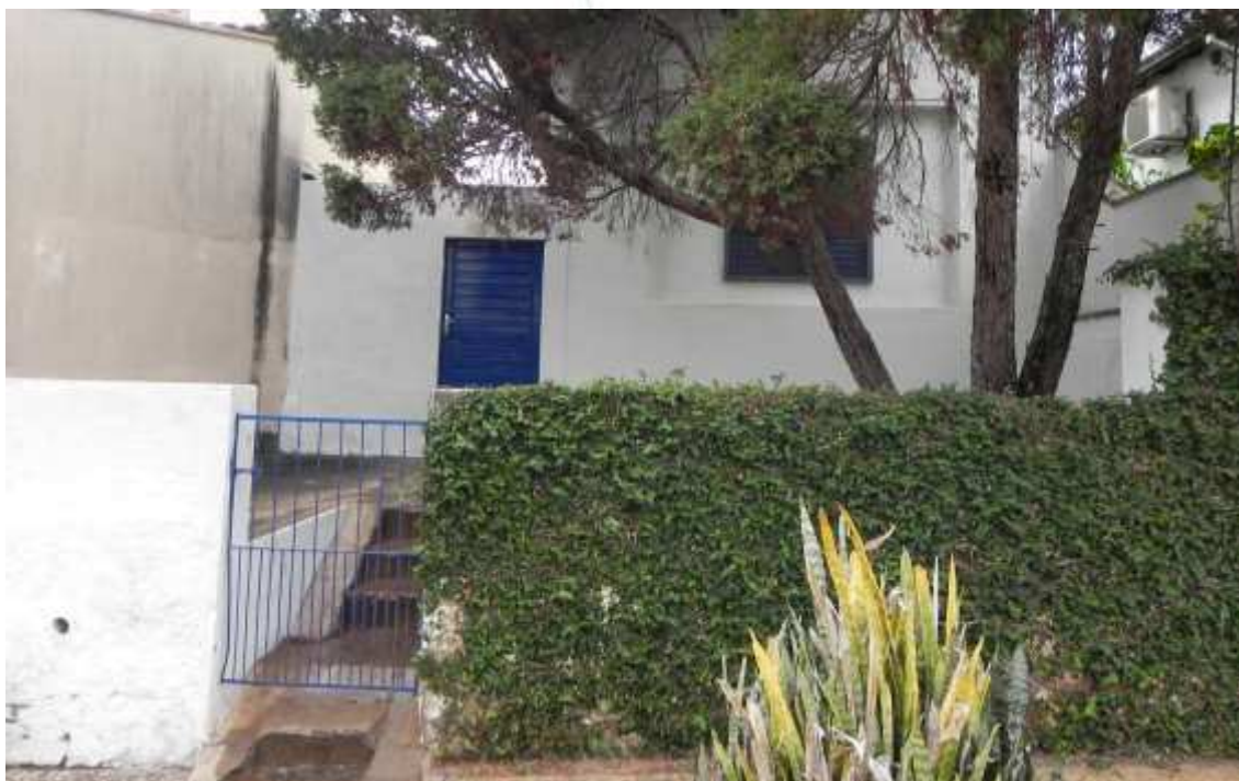
Foto 019: Entrada para lavanderia
