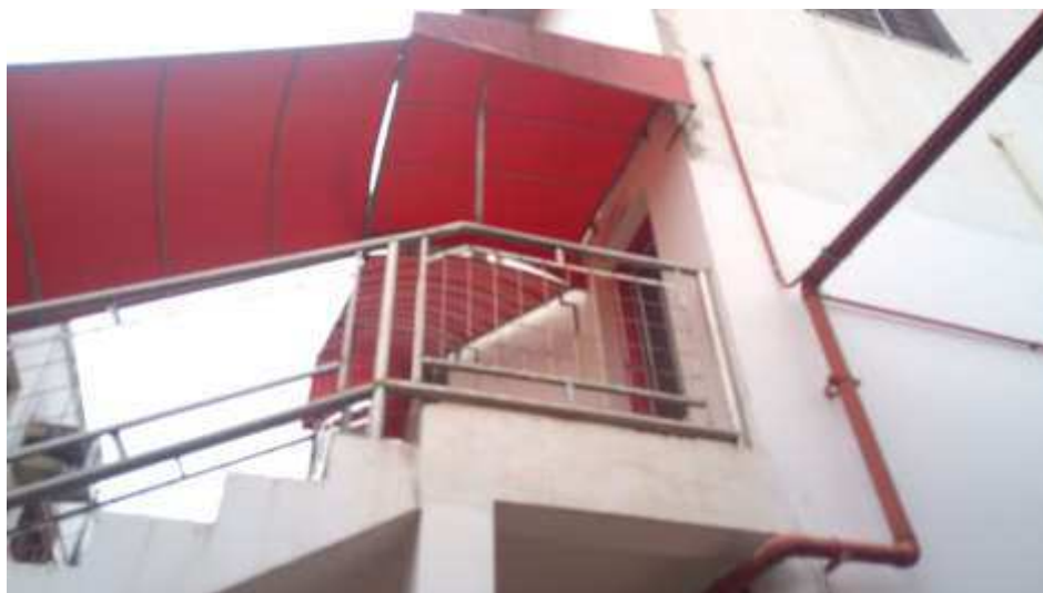
Foto 017: Entrada do refeitório.
