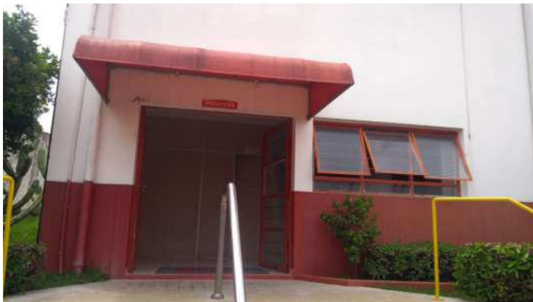
Foto 001: Entrada principal ( recepção )
