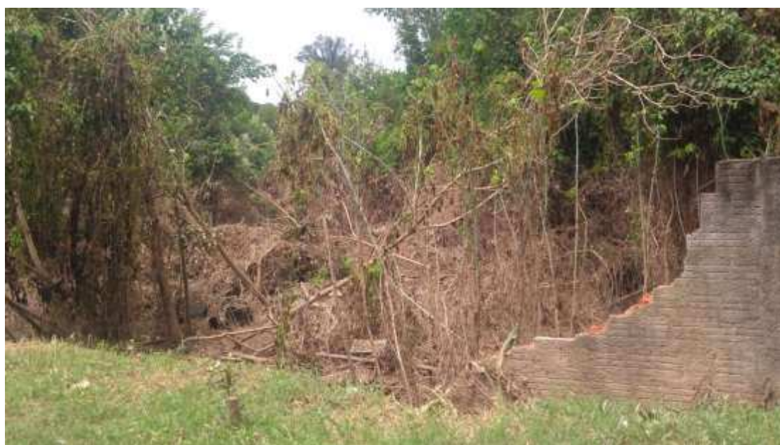
Foto 006: Muro da Recuperanda derrubado na enchente. (continuação)
