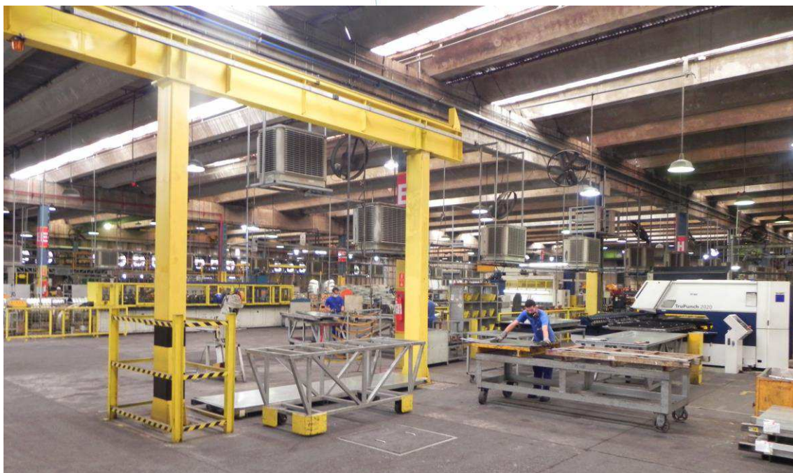
Foto 013: Ponte rolante operando normalmente
