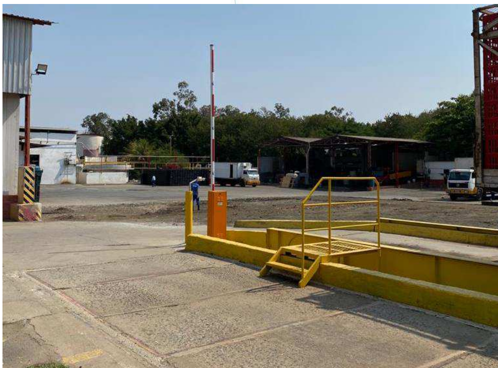
Foto 006: Ampla vista da área de carga e descarga de aves ( continuação )
