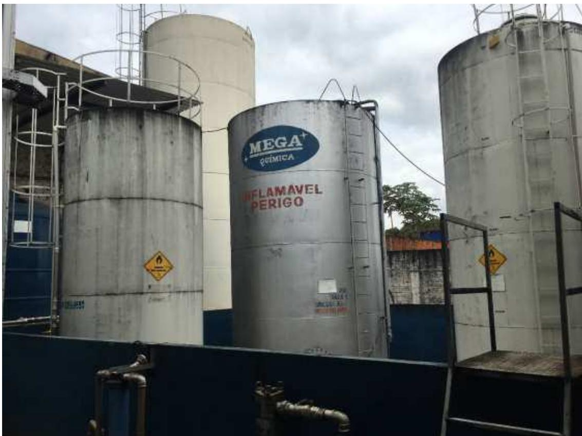
Foto 005: Tanques de estocagem de álcool.
