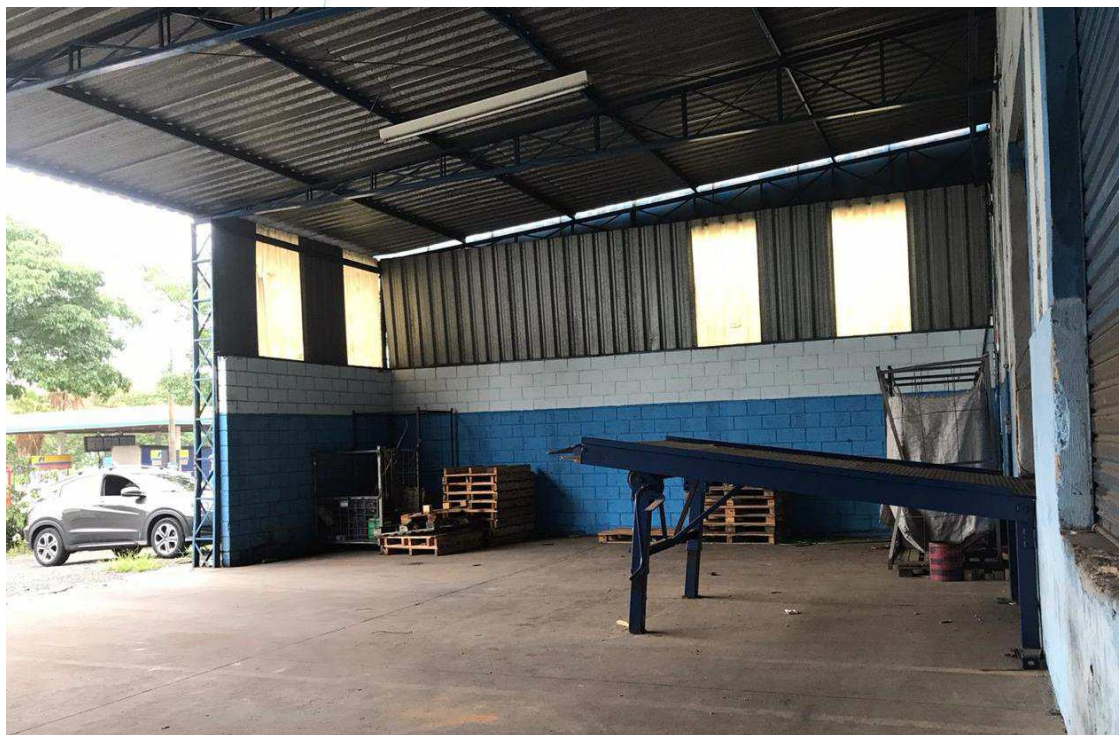
Foto 004: Doca de carga e descarga
