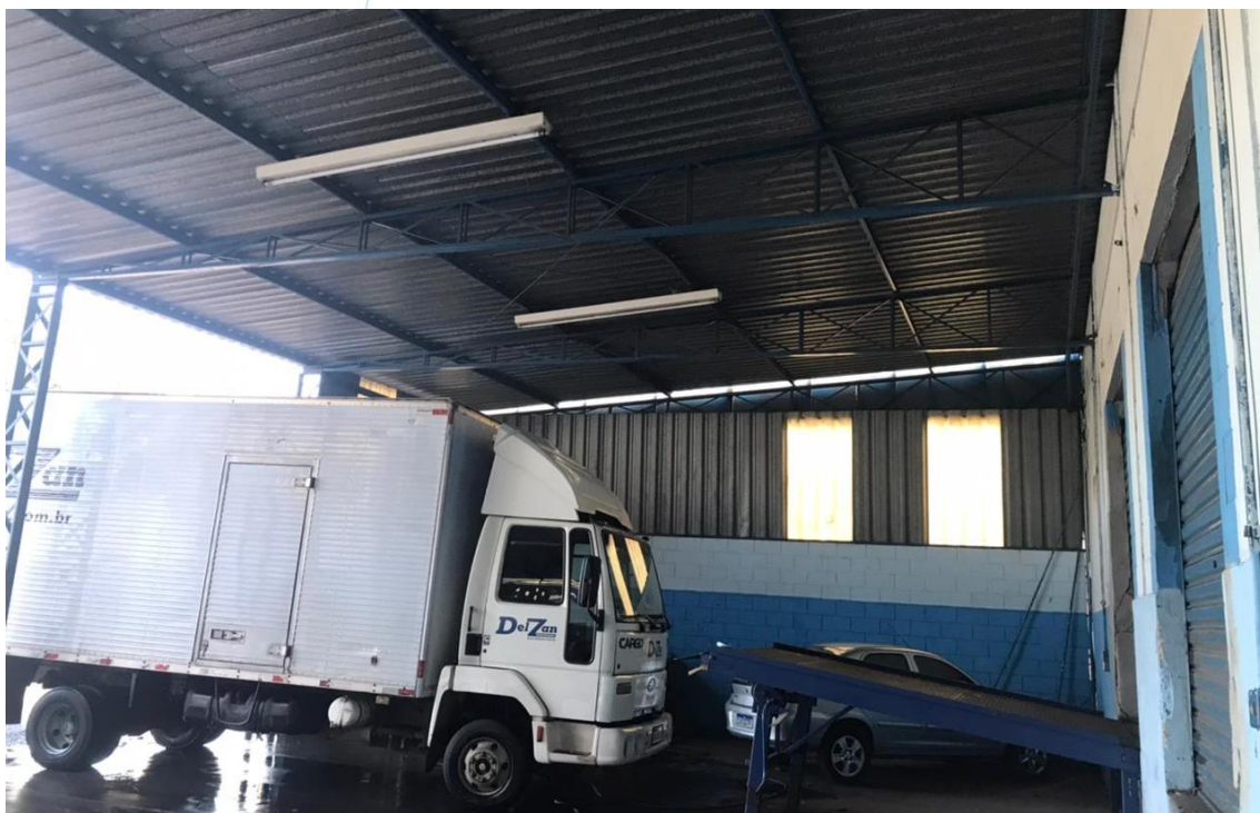
Foto 002: Doca de carga e descarga
