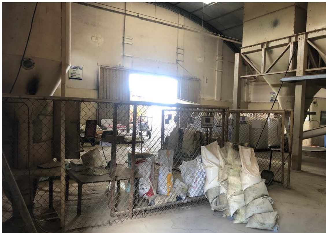
Foto 019: Equipamentos para locação de ração para aves.
