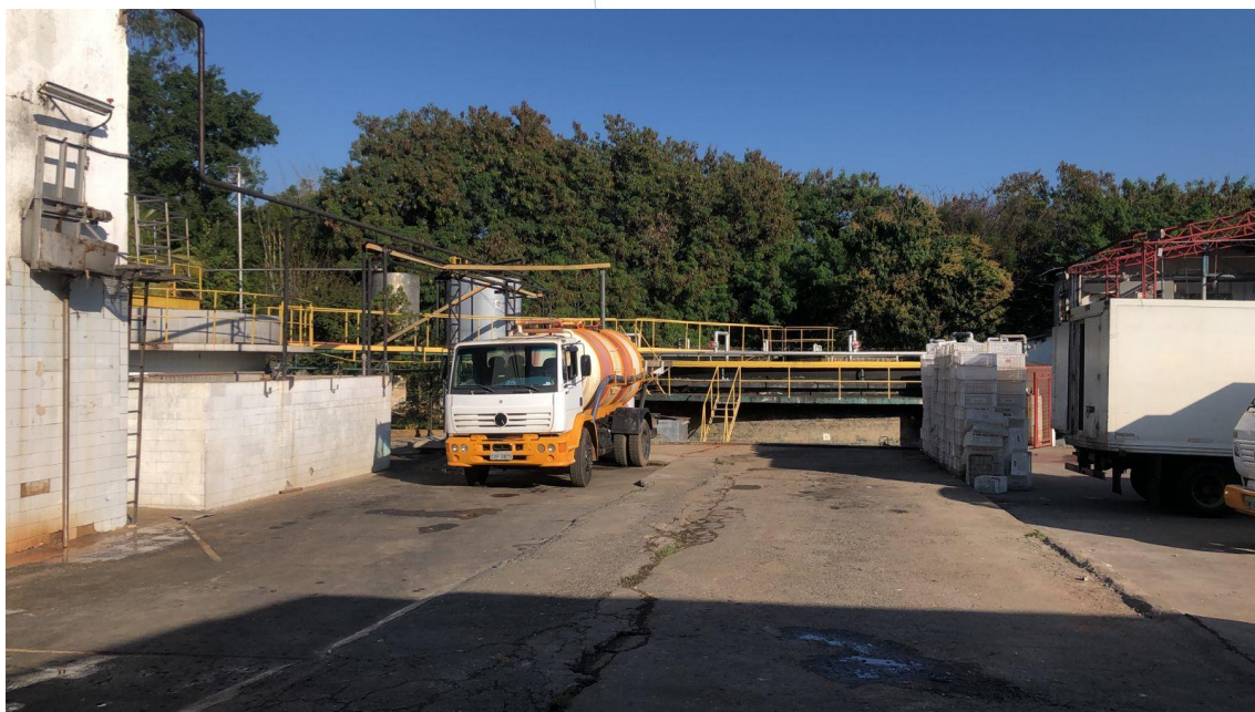
Foto 013: Estação de tratamento de fluídos da empresa
