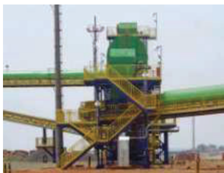
Sistema de limpeza e trituração de palha de cana
