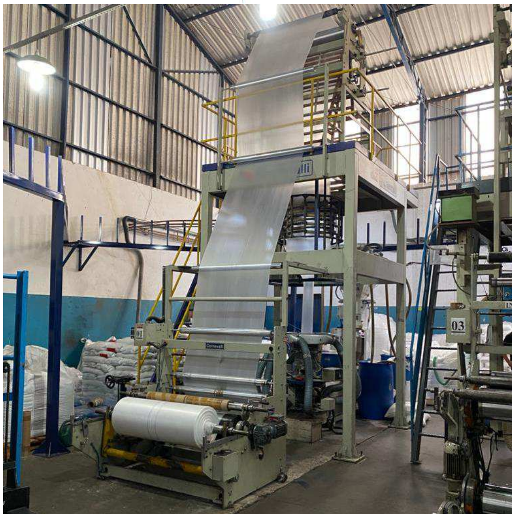
Foto 008: Maquinário operando ( continuação )
