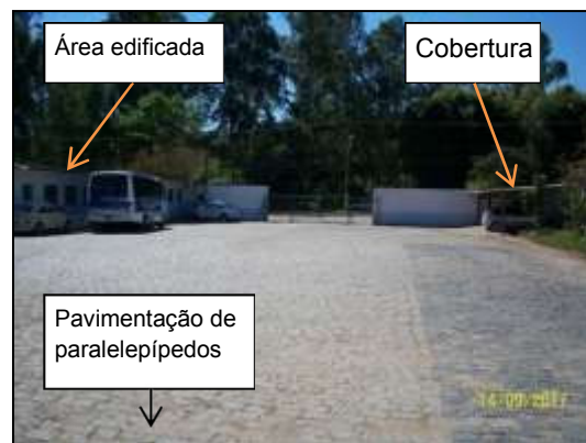
Foto 6: interior da área, vista do portão de acesso.
