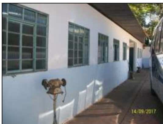
Foto 11: fachada da área edificada.
