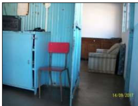
Foto 12: interior da área edificada.
