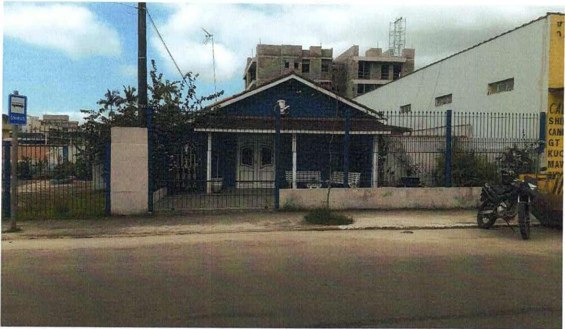
05 – FACHADA DA CASA
