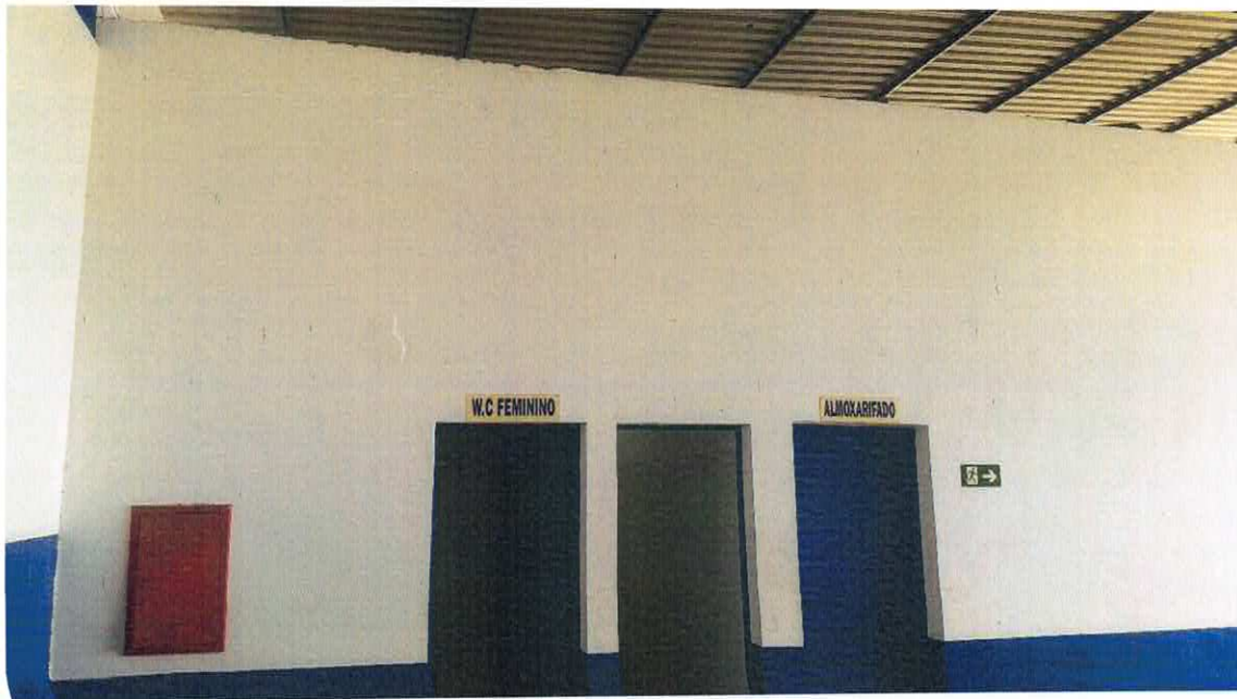
11 – AREA DE SANITARIOS DA OFICINA/ AMOXARIFADO
