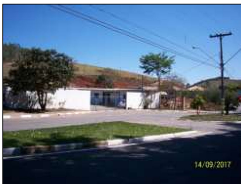
Foto 1: situação do imóvel na via de acesso
