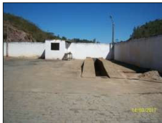
Foto 8: interior da área, vista da rampa do lavador.
