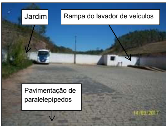
Foto 7: interior da área, vista da divisa dos fundos.
