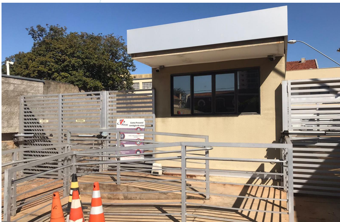
Foto 030: Portaria da entrada de veículos
