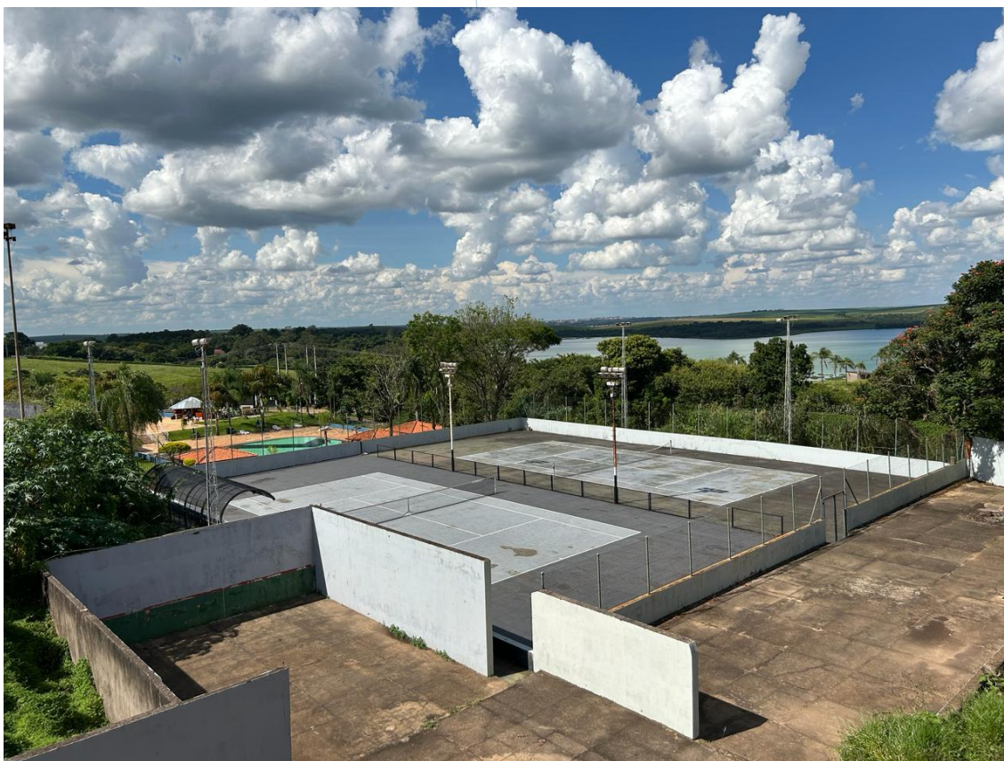
14 – Sede Social (quadras de cimento)
