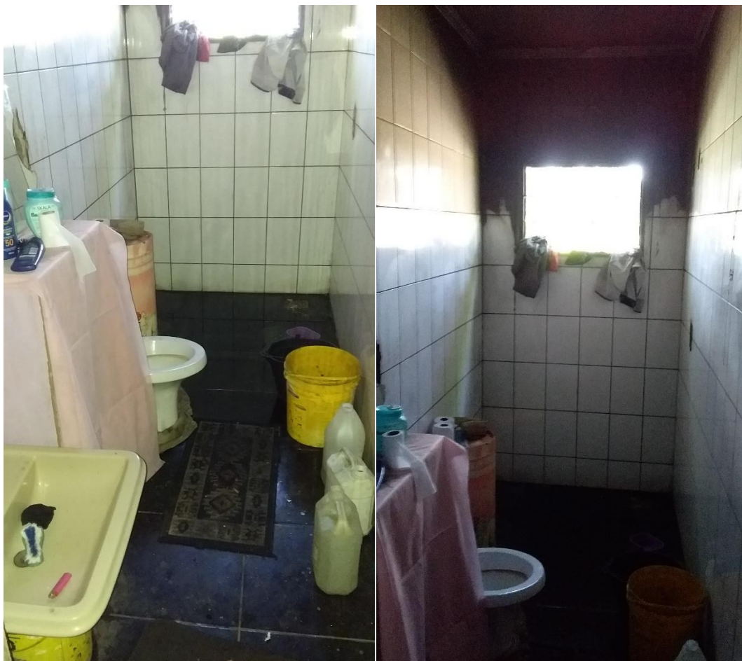
5 E 6- BANHEIRO PAVIMENTO SUPERIOR
