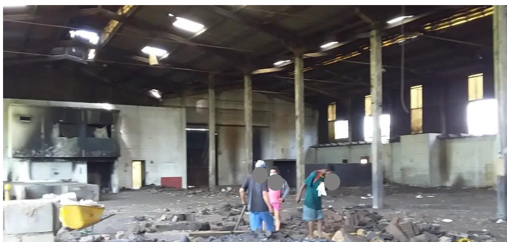
19- GALPÃO VISTA LATERAL DIREITA
