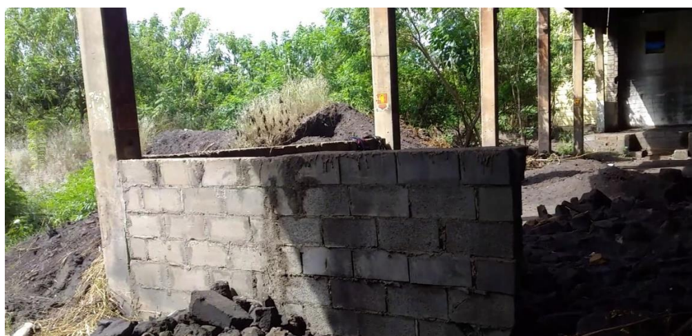
20- GALPÃO VISTA LATERAL ESQUERDA
