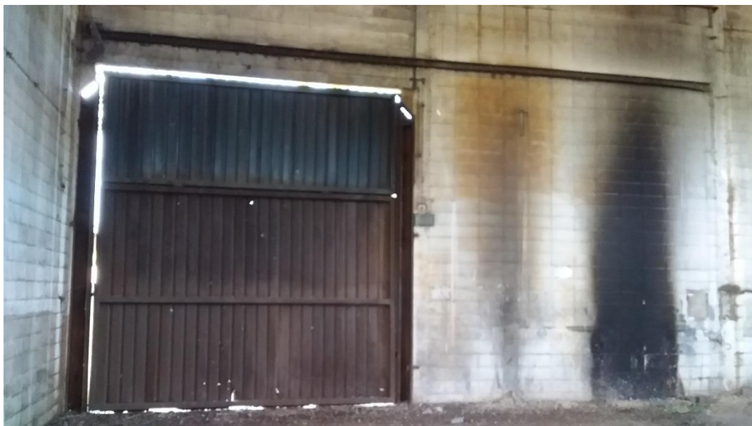
16- PORTÃO DE ACESSO AO GALPÃO
