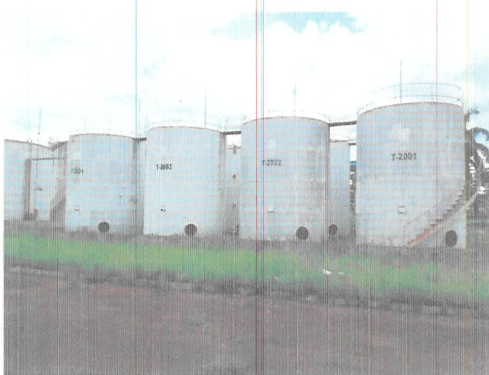
Área de tanques
