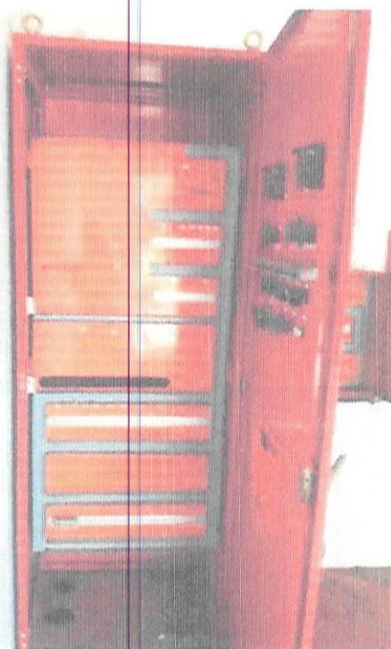
Painel da casa de bombas desmontado
