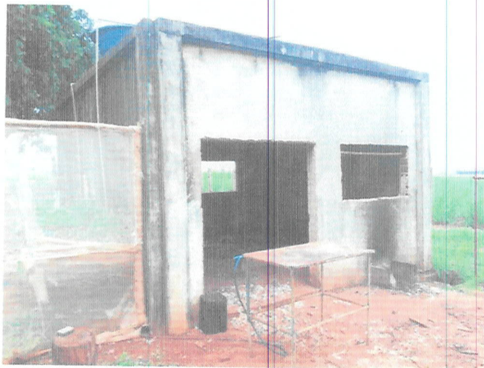
Edificação em construção sem identificação de uso
