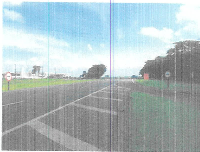
Rodovia Anhanguera – Via de saída dos imóveis
