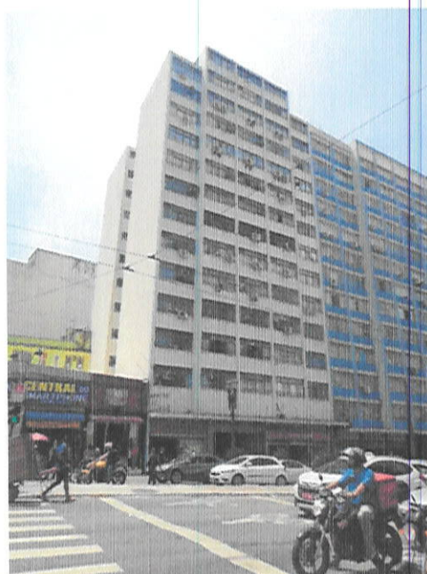
VISTA GERAL EDIFÍCIO ADOLPHO DROGUETTI
