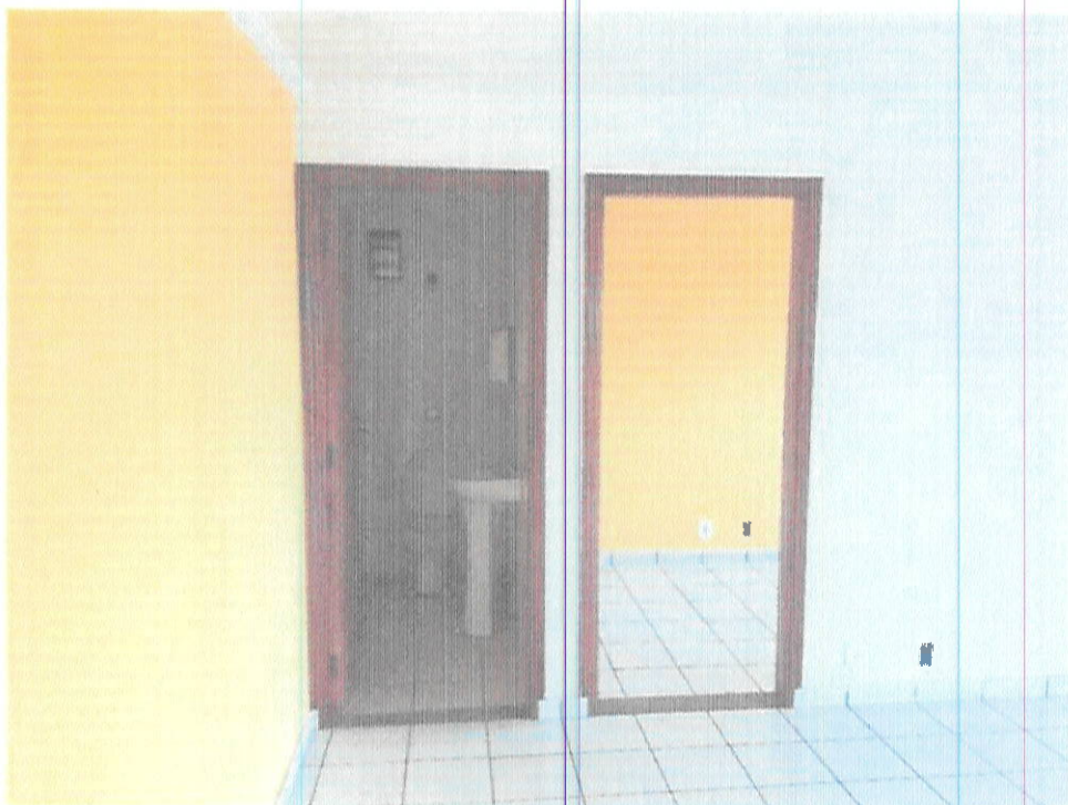
Cômodo 2 – Banheiro e Acesso ao Cômodo 3
