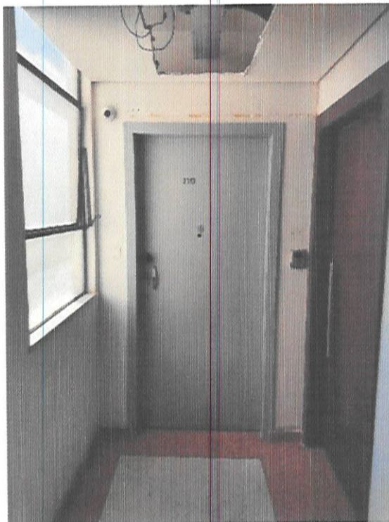
1- Porta de entrada na sala 119
