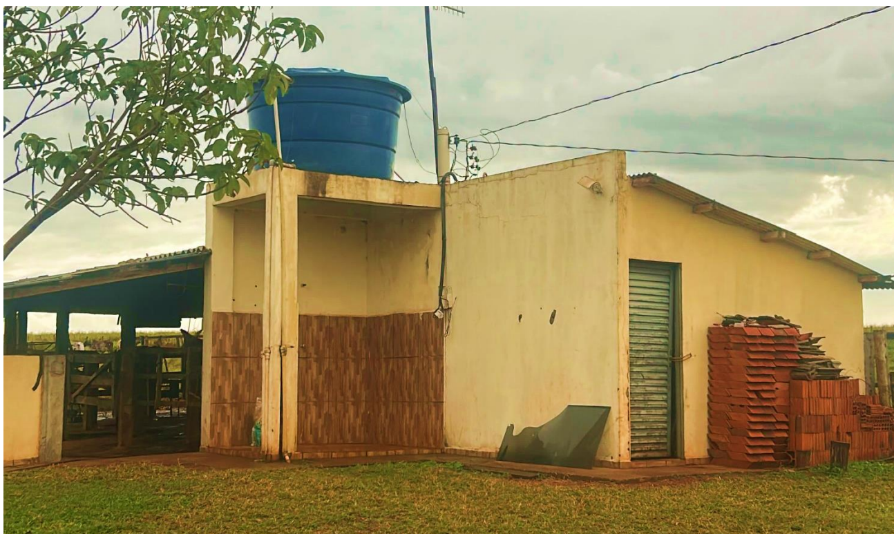
DEPÓSITO DE DEFENSIVOS
