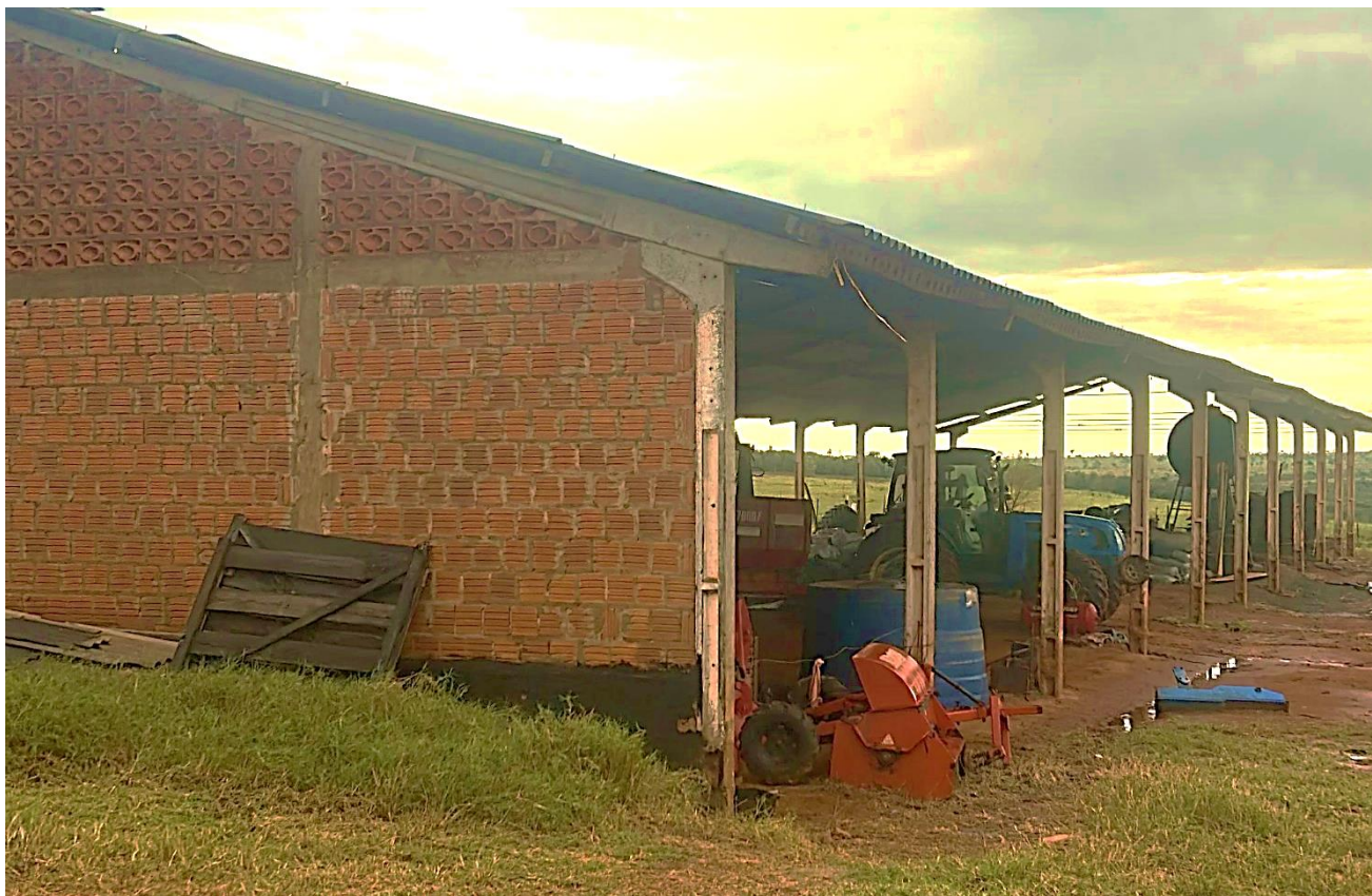
BARRACÃO DE MAQUINÁRIOS
