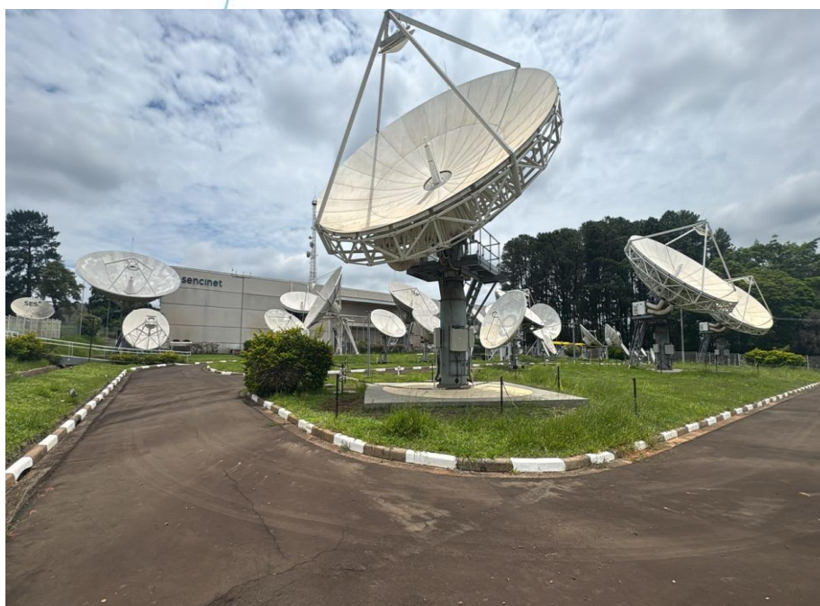
Foto 034: Pátio de Antenas ( continuação )
