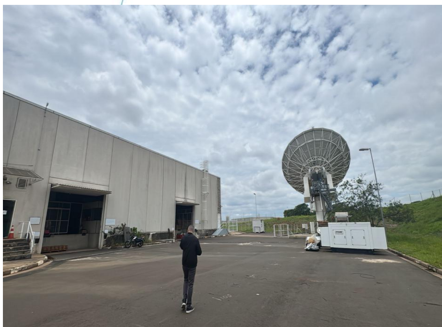
Foto 026: Vista Externa do Prédio
