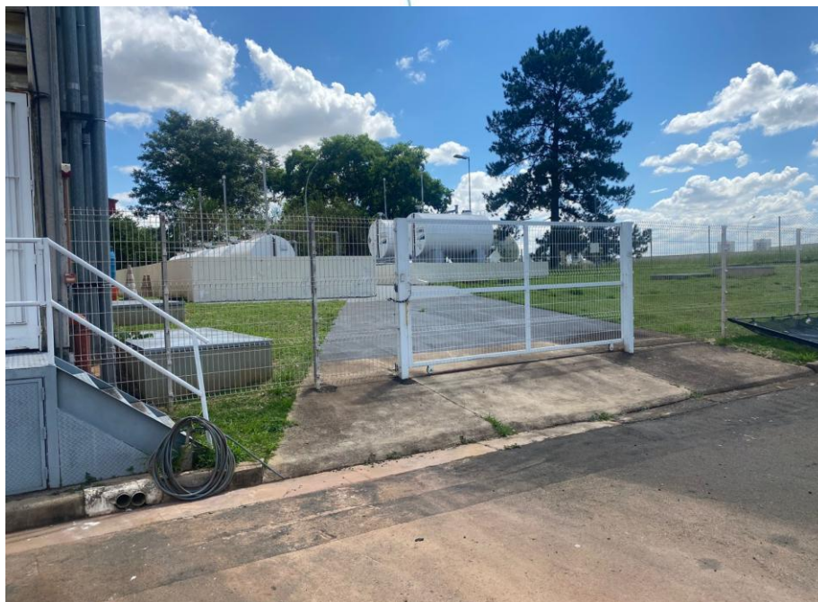
Foto 027: Tanques de Diesel
