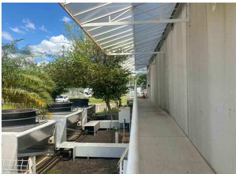
Foto 026: Vista Externa do Prédio
