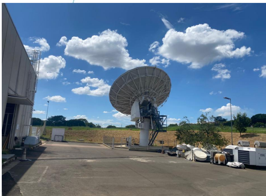
Foto 034: Pátio de Antenas ( continuação )
