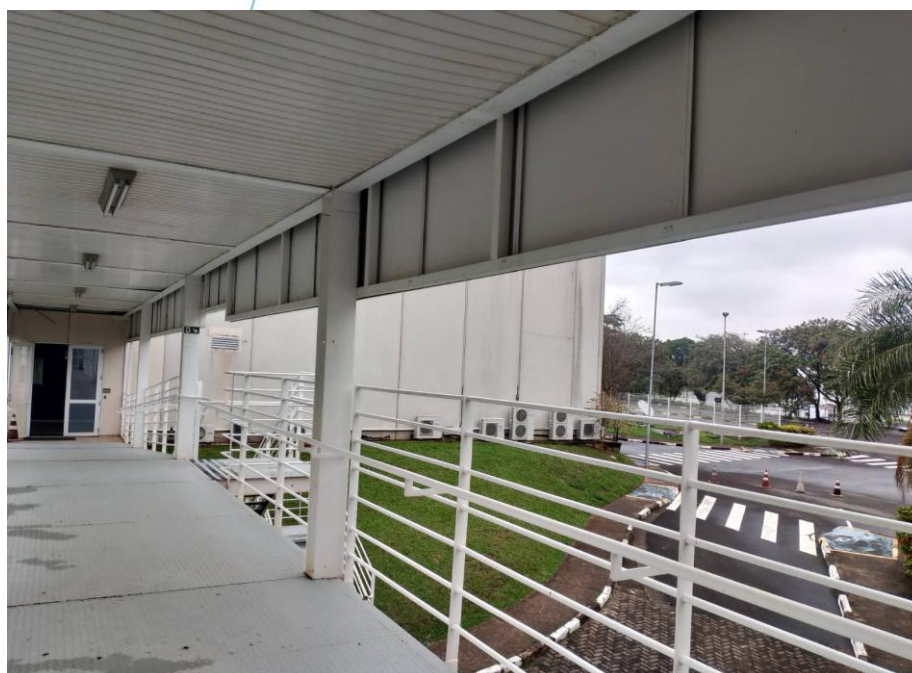
Foto 026: Vista Externa do Prédio
