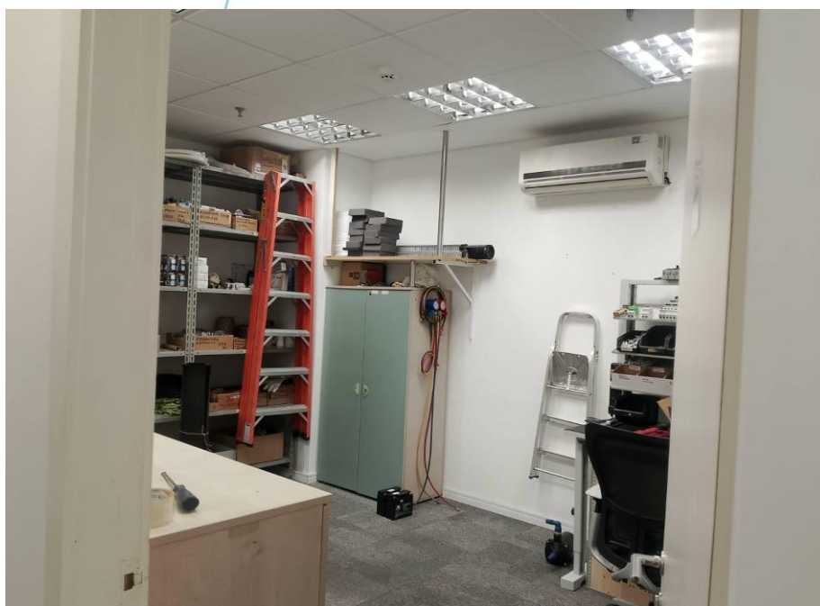
Foto 018: Sala de Manutenção
