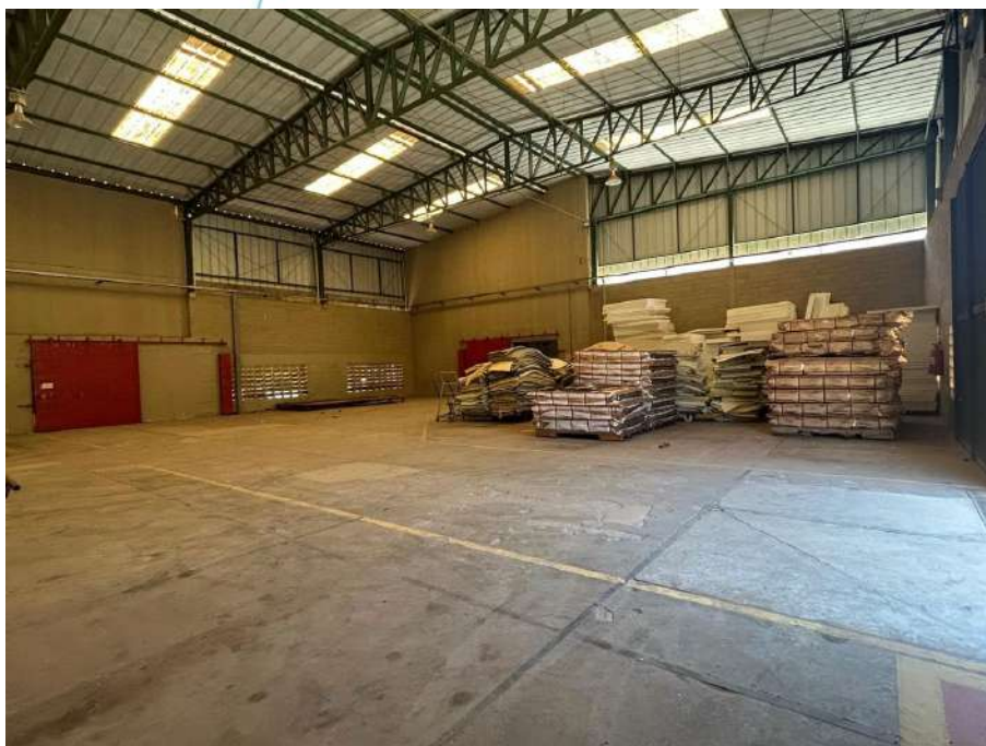
Foto 024: Parque Fabril equipamentos (continuação-13)
