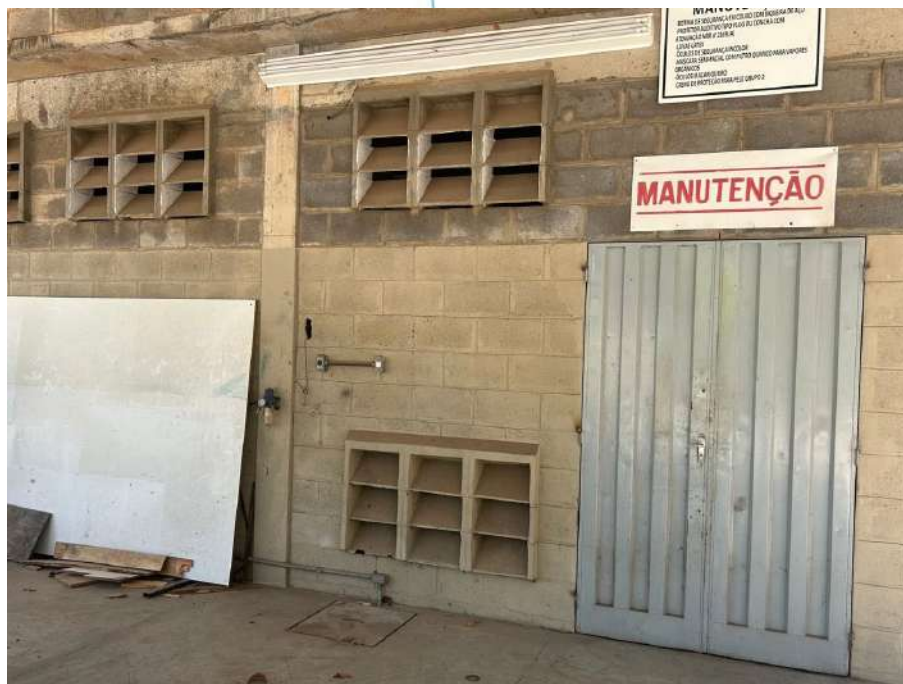
Foto 037: Setor de Manutenção
