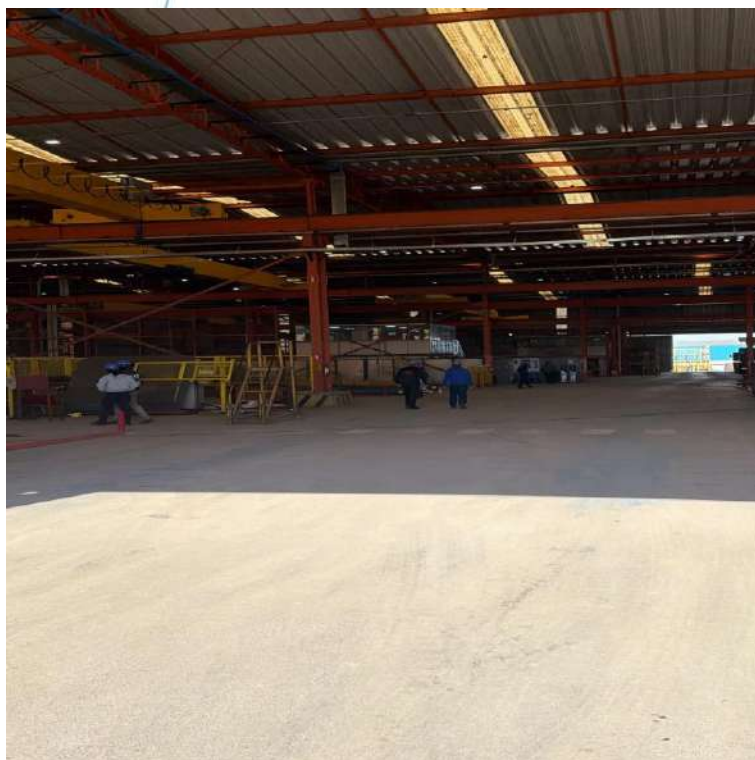
Foto 010: Operação de Corte e Dobra de Aço (Continuação)
