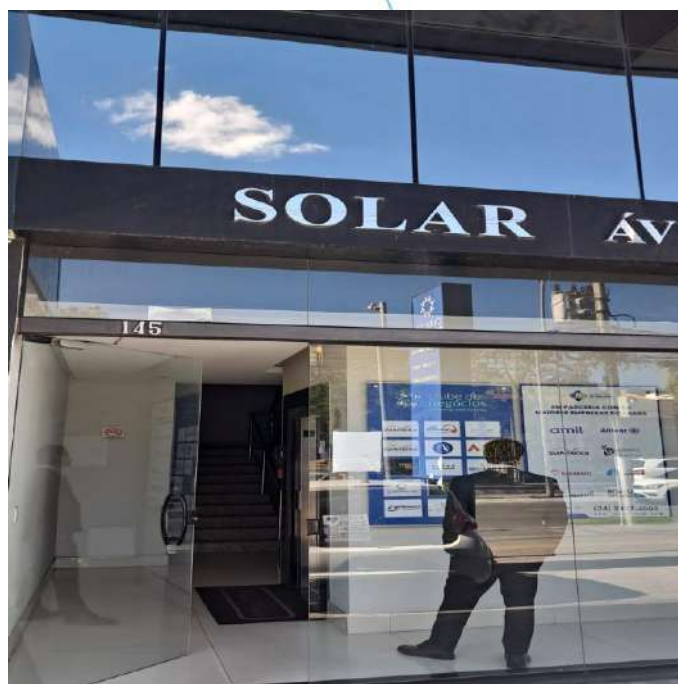
Foto 071: Fachada do Galpão (Continuação)
