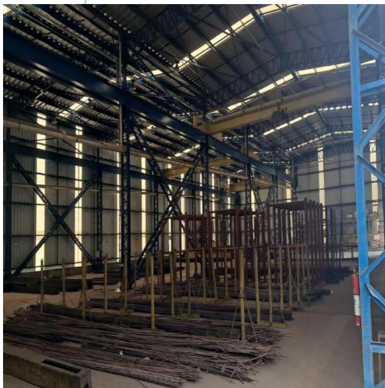
Foto 025: Galpão 5 Vista Ampla
