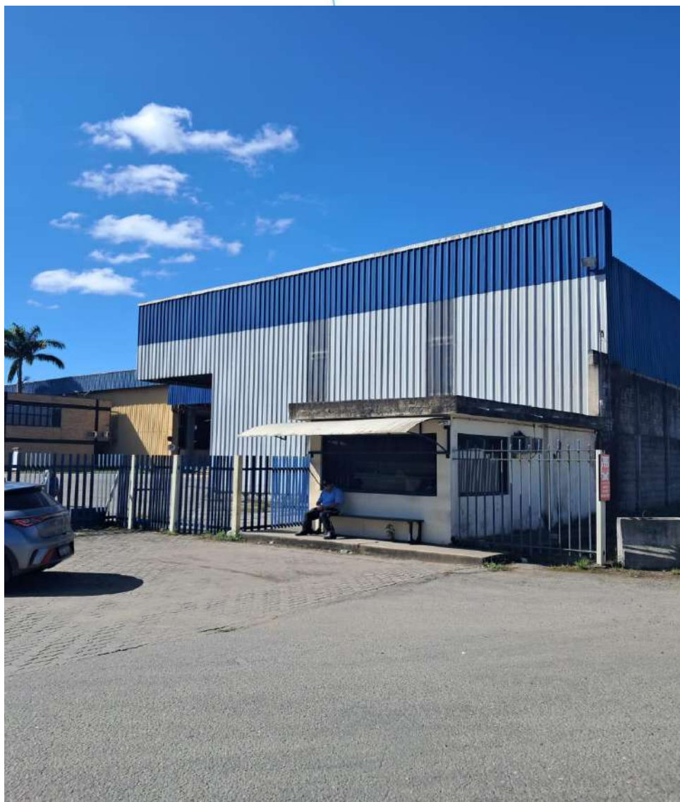
Foto 070: Fachada do Galpão
