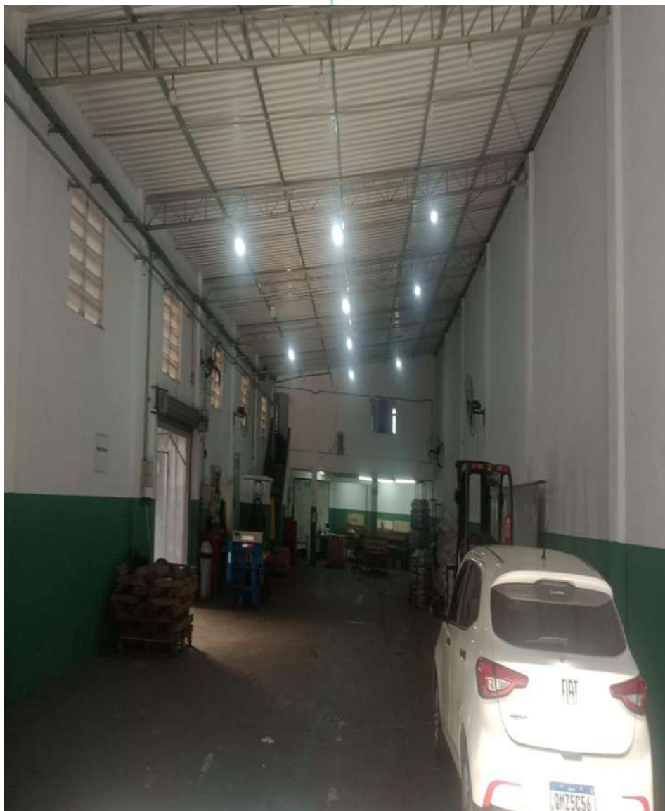
Foto 091: Galpão Vista Interna (Continuação)
