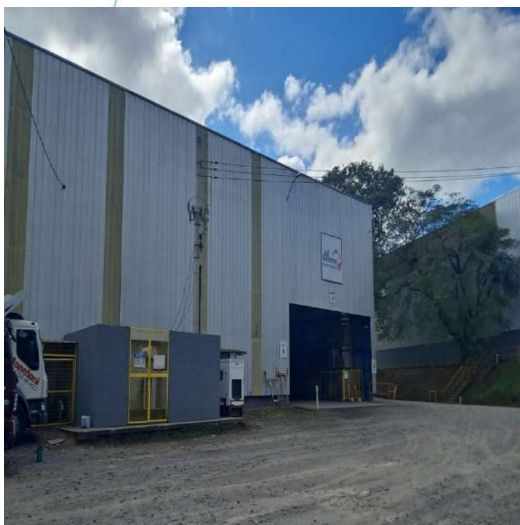
Foto 023: Galpão 5 Vista Externa
