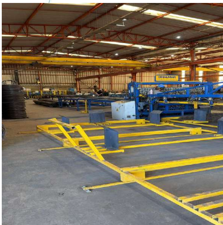
Foto 014: Operação de Perfilação de Aço ( Continuação )
