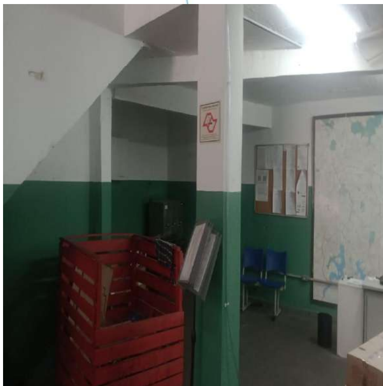
Foto 085: Galpão Vista Interna (Continuação)
