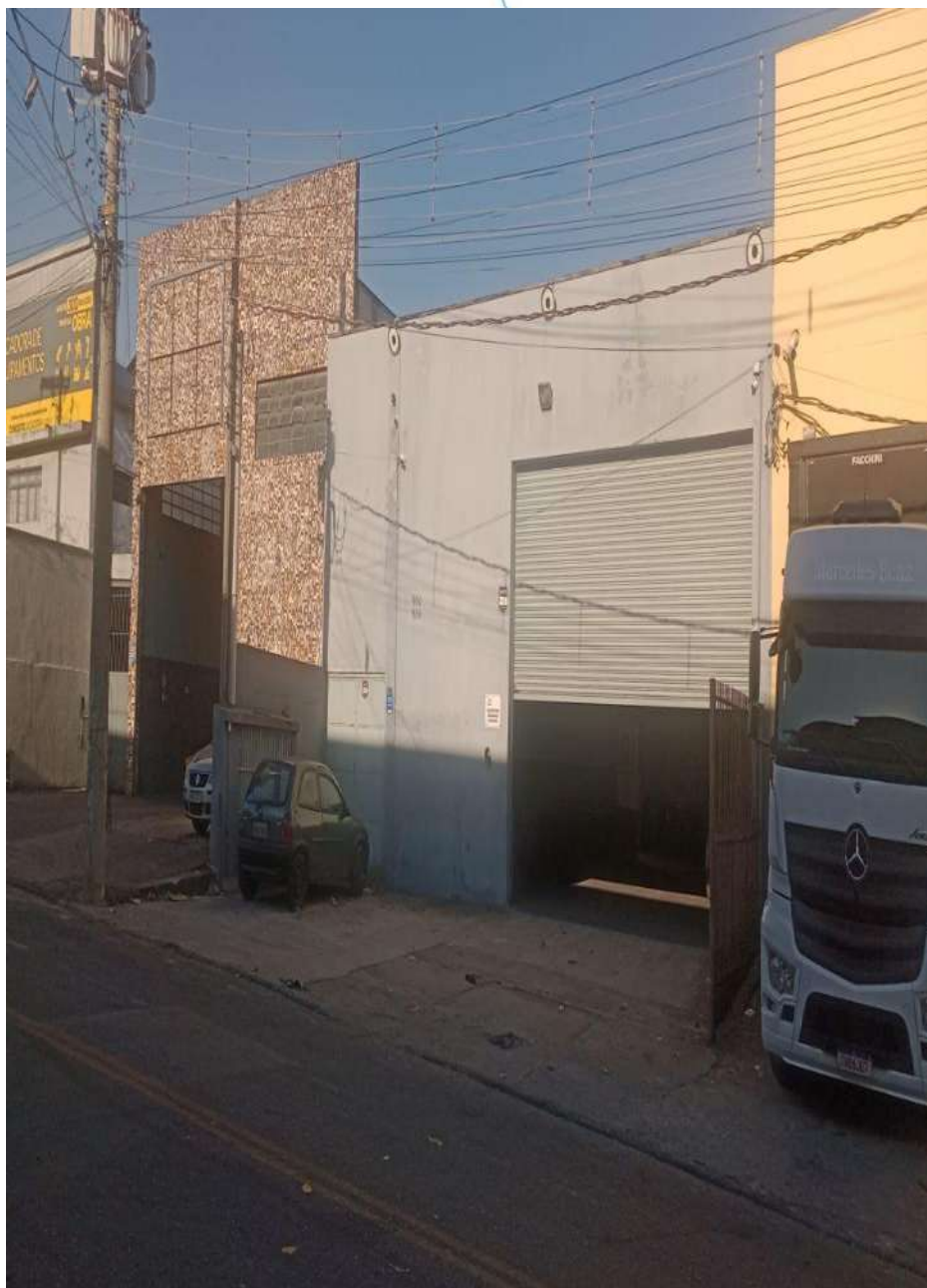
Foto 082: Fachada do Galpão
