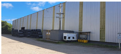
Unidade Industrial Valença | Fonte: GT
