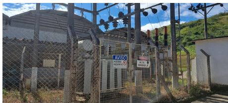
Unidade Industrial Valença | Fonte: GT
