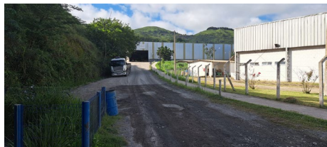
Unidade Industrial Valença | Fonte: GT
