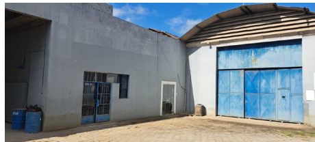
Unidade Industrial Valença | Fonte: GT
