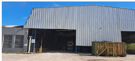
Unidade Industrial Valença | Fonte: GT
