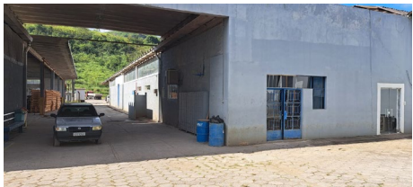
Unidade Industrial Valença | Fonte: GT
