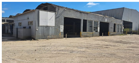
Unidade Industrial Valença | Fonte: GT
