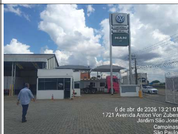
12 - Guarita de assistência técnica
