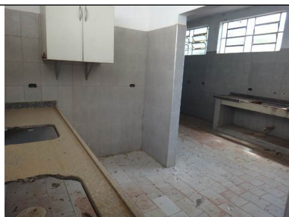
Cozinha – Prédio Escritório
