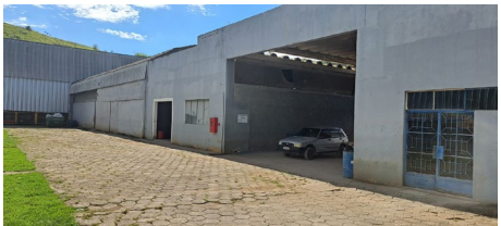
Unidade Industrial Valença | Fonte: GT
