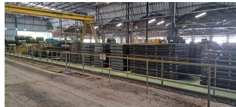
Unidade Industrial Valença | Fonte: GT
