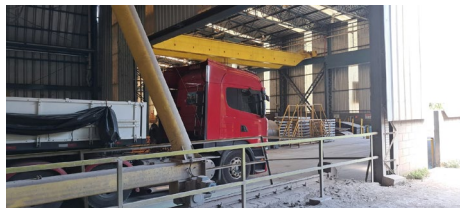
Unidade Industrial Valença | Fonte: GT
