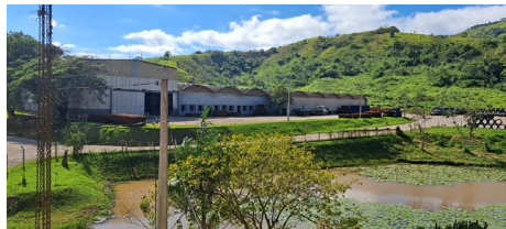
Unidade Industrial Valença | Fonte: GT
