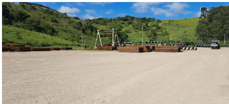
Unidade Industrial Valença | Fonte: GT
