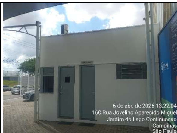
14 - Guarita de assistência técnica
